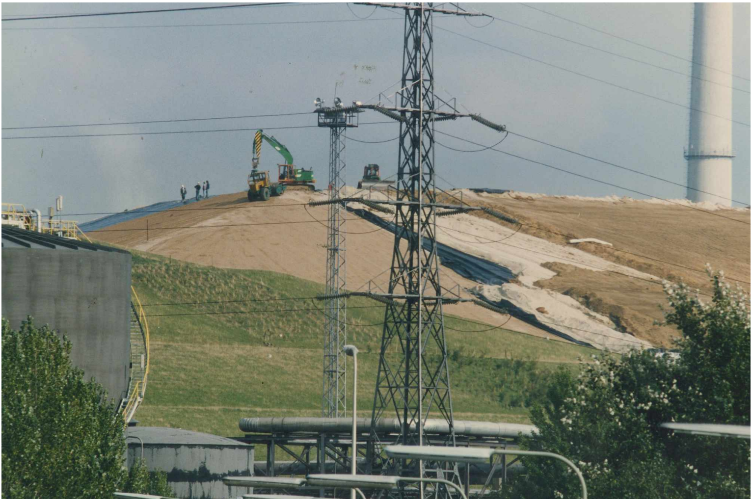
Het afdekken van de Mauritsdeponie op het DSM-terrein in 1994.
