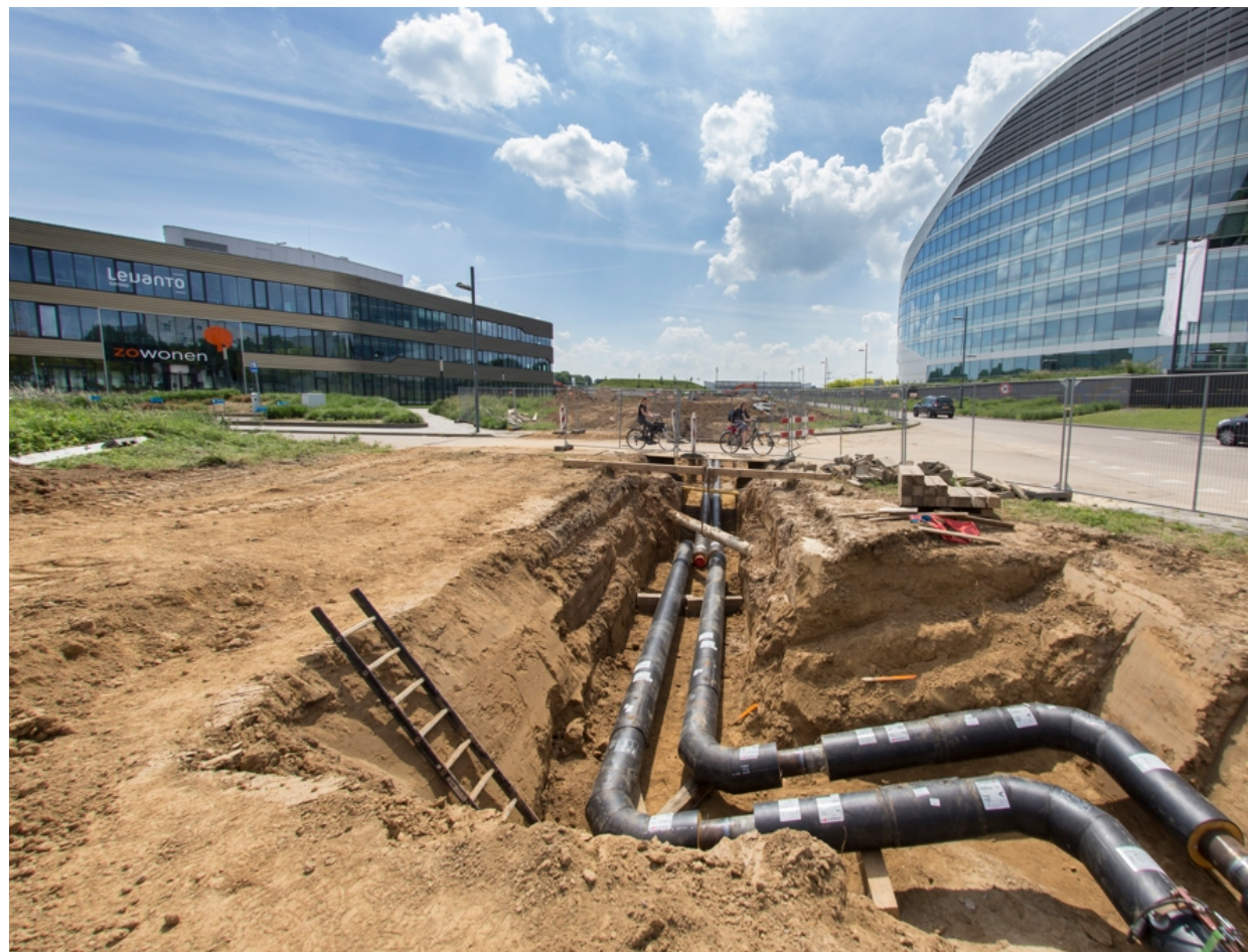
Langs het spoor in Sittard wordt de pipleiding voor Het Groene Net aangelegd. FOTO MITCHELL GIEBELS
